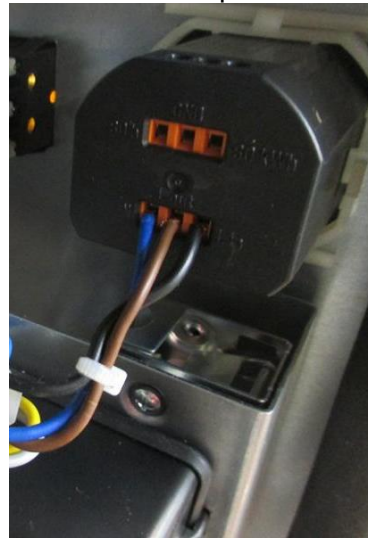
6. Zähler mittels Spannklemmer sichern.
