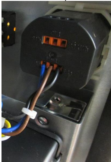
6. Zähler mittels Spannklemmer sichern.
