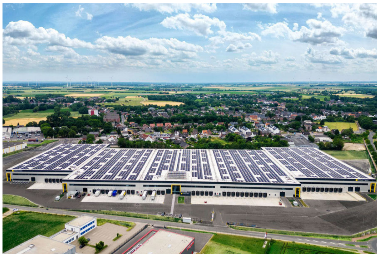
Die 50.000 m 2 Dachfläche wird vollständig für Photovoltaik und Solarthermie genutzt und ist damit eine der größten gebäudegebundenen Anlagen in NRW. Der Bau entspricht dem Energieeffizienzlevel 40 Plus. Also dem Wert eines Niedrigenergiehauses.
