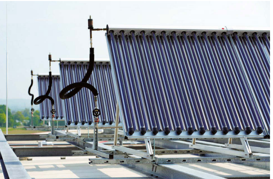
Auf dem Dach wurden neben den PV Kollektoren auch 48 große Sonnenkollektoren installiert, die in der Lage sind auch im Winter Wärme zu liefern. Die ganze Steuerung der Anlage wird von einer künstlichen Intelligenz (KI) vorgenommen.
